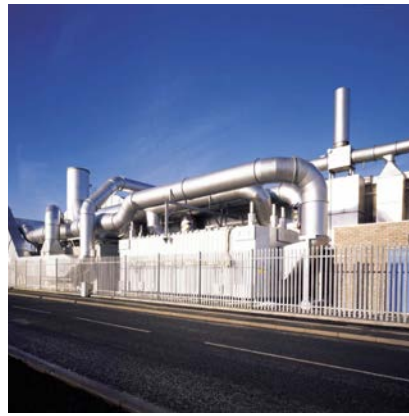
Industrial Fan Control
